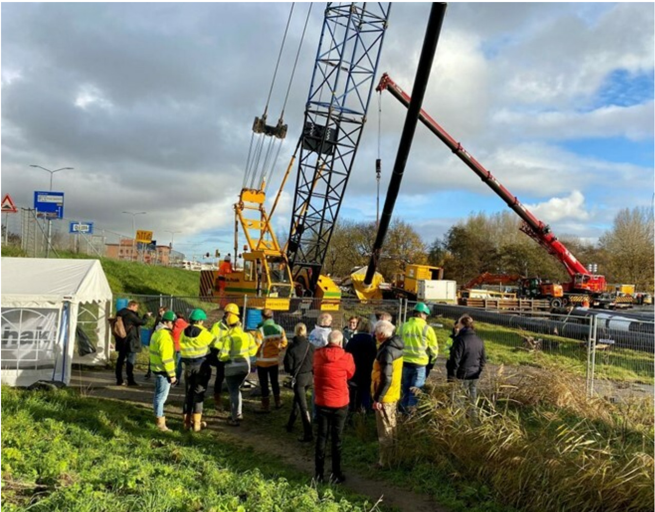
De boogboring voor WarmtelinQ in Delft onder de Laan der Verenigde Naties was een spectaculaire technische prestatie. Op 7 december 2022 kregen bewoners uit de buurt gelegenheid om een kijkje te nemen en vragen te stellen.
